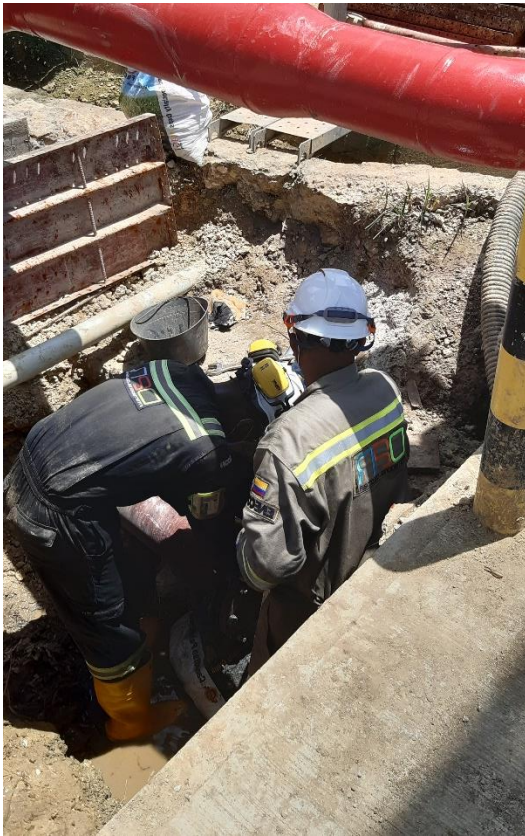
Gráfico 5 Trabajos de mantenimientos con la tubería
