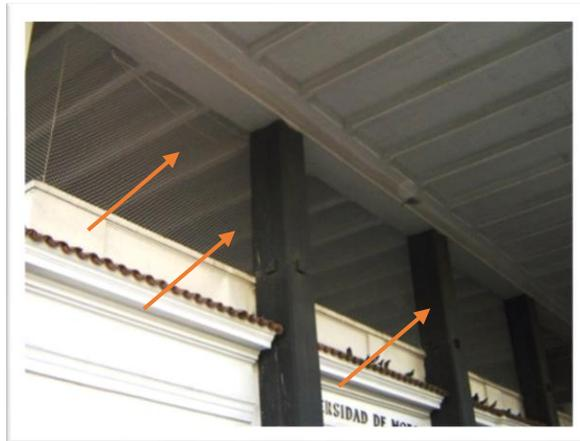
**Imagen 11.** Red anti intrusión de palomas en planta libre de un edificio
