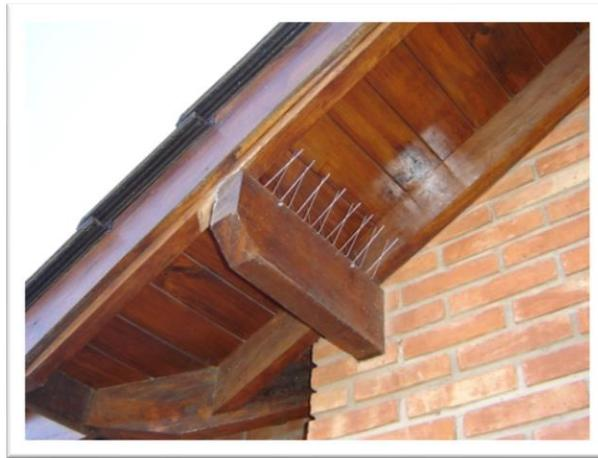
**Imagen 9.** Púas antiposado de palomas en viga bajo techo madera
