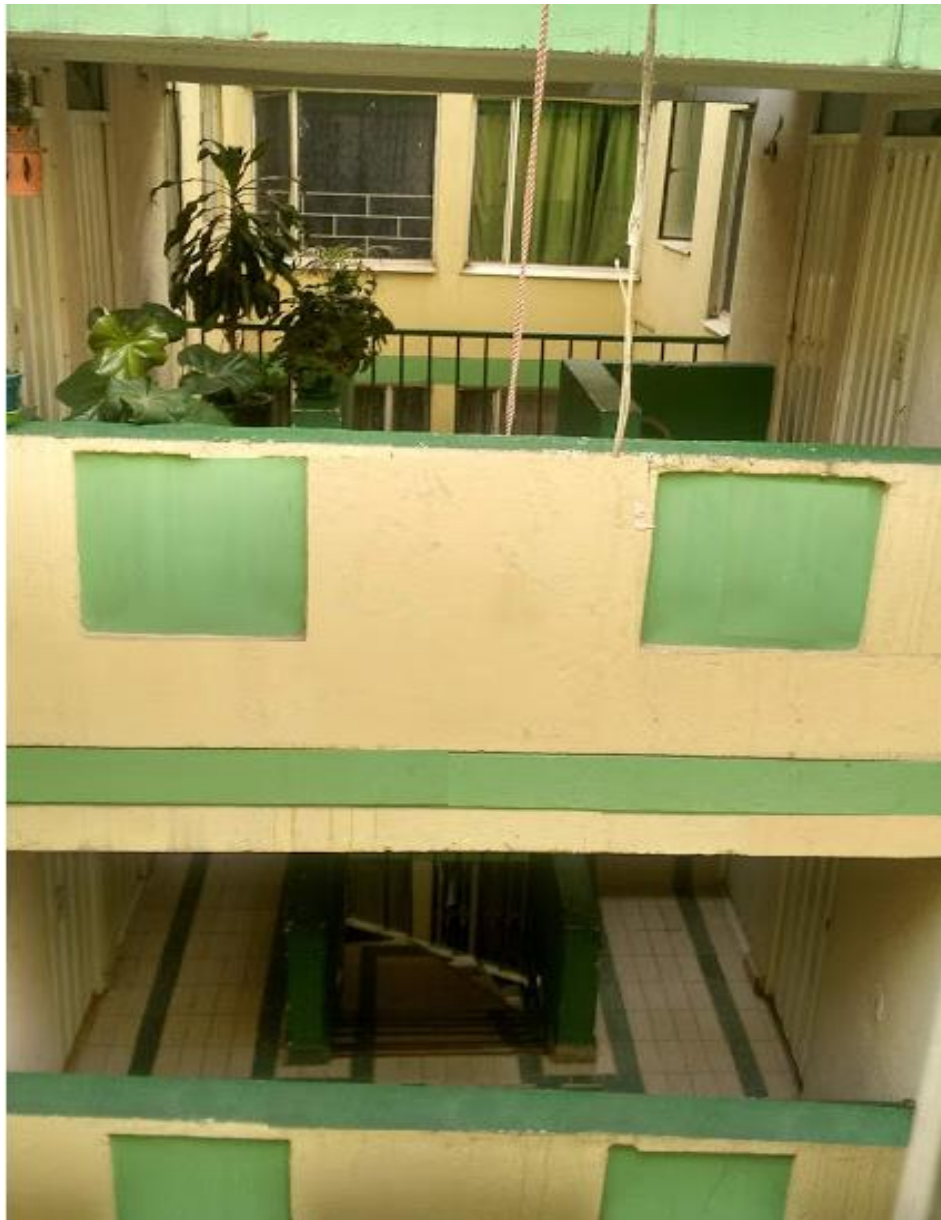
Figura 26. Vista torre 2A de dos pisos para instalación de cámara de seguridad
