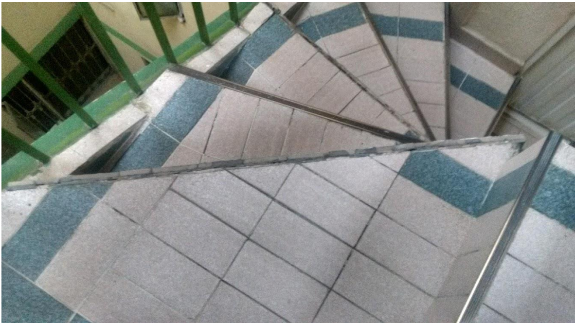
Figura 1. Escaleras donde se han perdido los pirlanes o esquineros.
