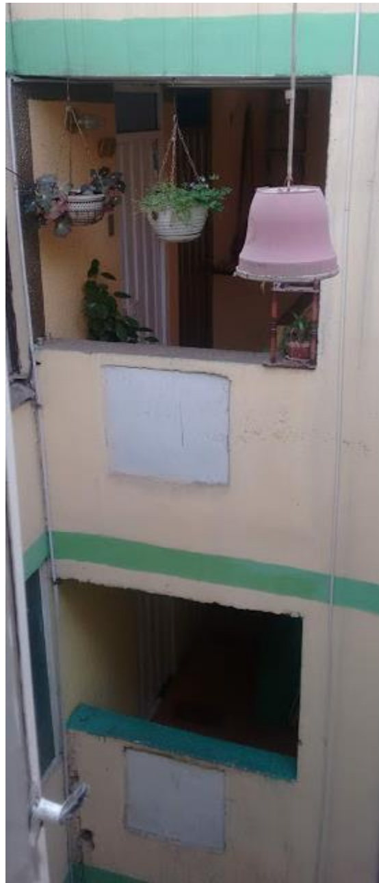
Figura 27. Vista torre 2B de dos pisos para instalación de cámara de seguridad
