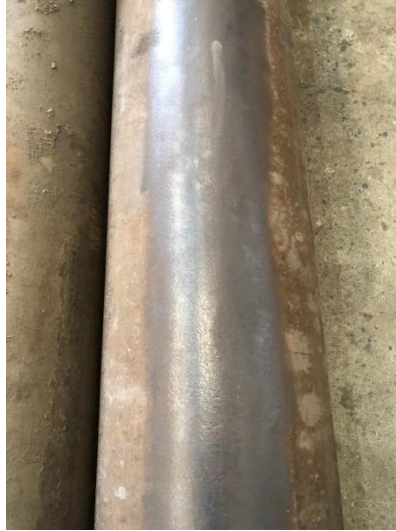
Figura 15. Acabado limpieza con grata copa.
